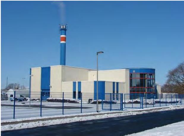
Das geothermische Heizwerk Neustadt-Glewe (Landkreis Ludwigslust – Parchim) erschließt energetisch nutzbares Thermalwasser mit einer Temperatur von 100 °C. Dazu wurden eine Förder- und eine Reinjektionsbohrung mit einer Endteufe von 2.450 bzw. 2.335 m niedergebracht. Der Abstand zwischen den beiden Bohrungen beträgt etwa 1.500 m. Je Tiefenkilometer kann eine Wärmezunahme um etwa 30 K angenommen werden.
